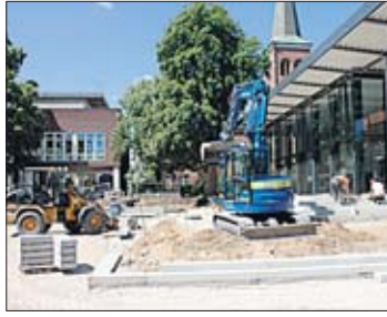
Trotz Treppen: Der neue Zugang zum Helms-Museum wird auch rollstuhlgerecht. FOTO: GIPP
